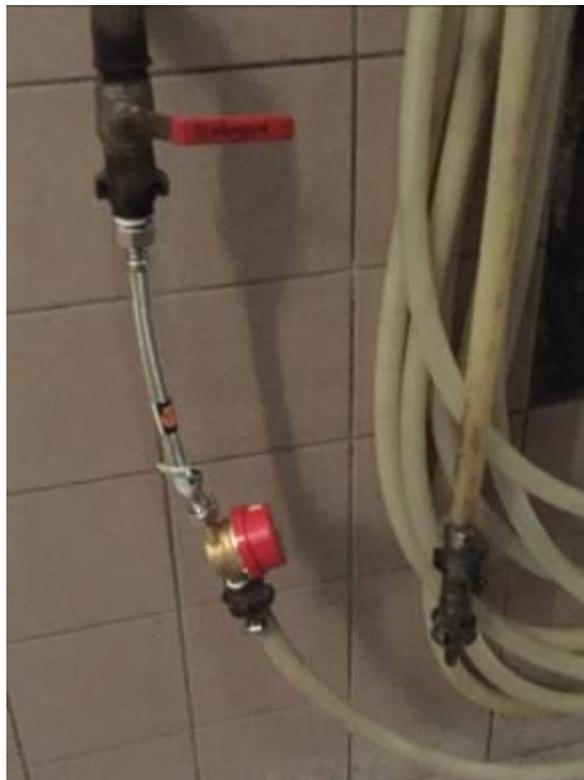
Figure 3 : Compteur d'eau branché sur une arrivée d'eau en cave
